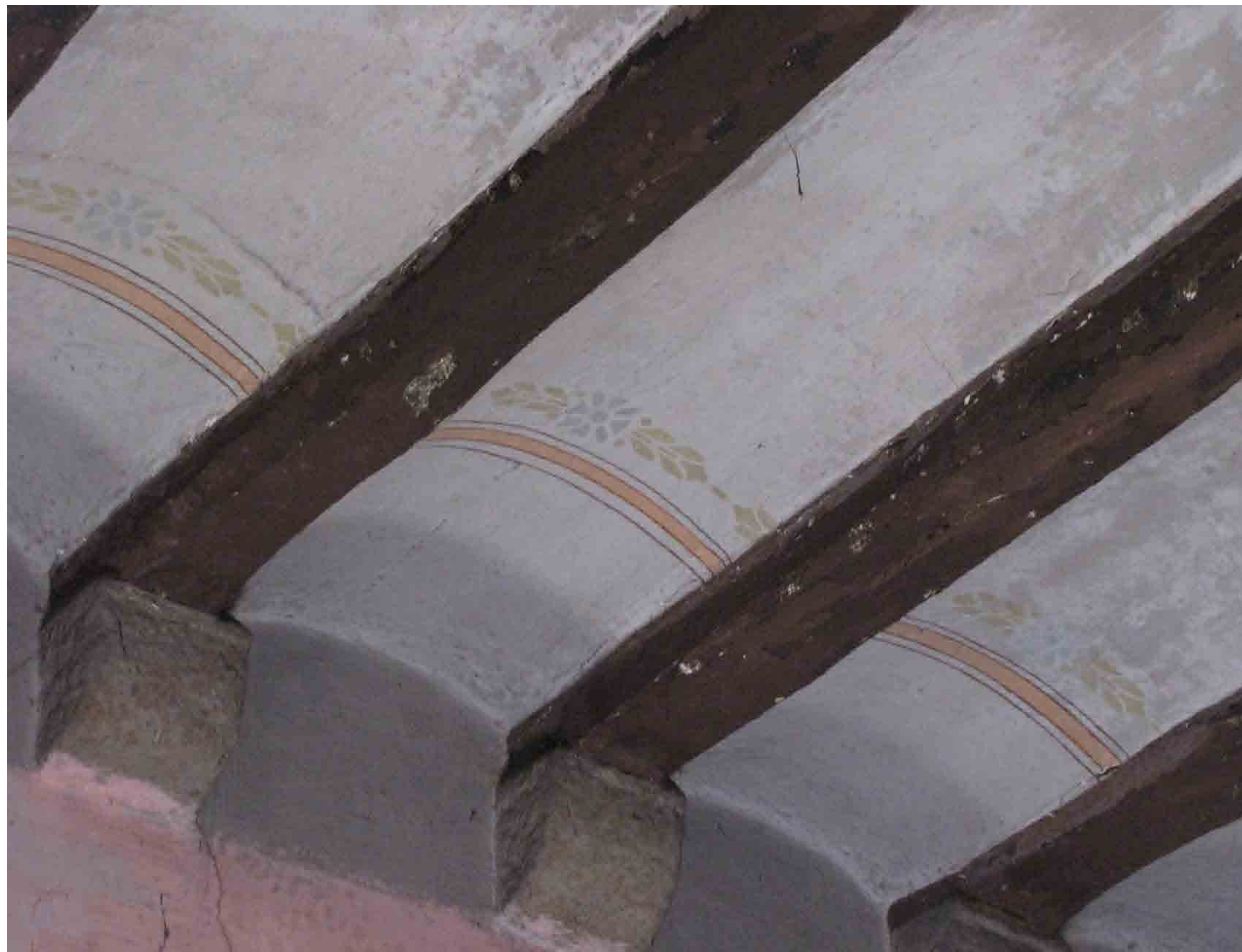
Sostre d'una de les habitacions de la planta baixa amb les bigues recolçades en mènsules de pedra. Aquesta habitació conservava la pintura de final del segle XIX o principis del segle XX. Albert Cartagena/Museu de Badalona. AI
